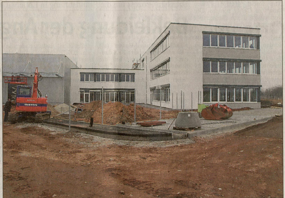
Rasante Entwicklung: Ein halbes Jahr nach dem ersten Spatenstich bezieht Dambach Lagersysteme bereits den Neubau in Bischweier. Dort wird ab kommendem Montag gearbeitet. Foto: privat
